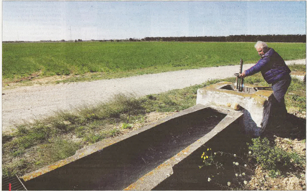
Les nombreux canaux d'irrigation dans la Crau permettent d'arroser 13 500 ha de prairies et d'alimenter la nappe.
