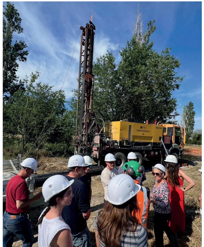
et Minières ainsi que trois forages entre 50 et 100 mètres de profondeur dans le cadre d'un marché public passé avec les entreprises IMAGEAU et FORASUD. Les essais de pompage réalisés dans les ouvrages ont confirmé la présence d'eau dans deux des trois ouvrages.
